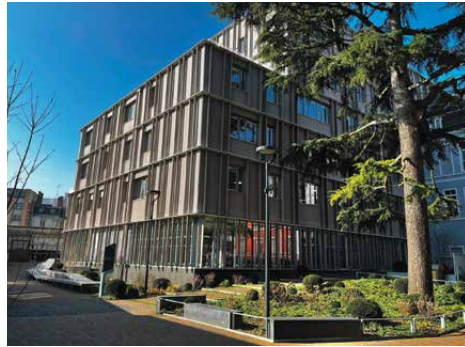
> Louise Weiss , premier bâtiment à avoir fait l'objet d'une Analyse en Cycle de Vie complète pour sa construction (2x moins de GES qu'un bâtiment classique).
